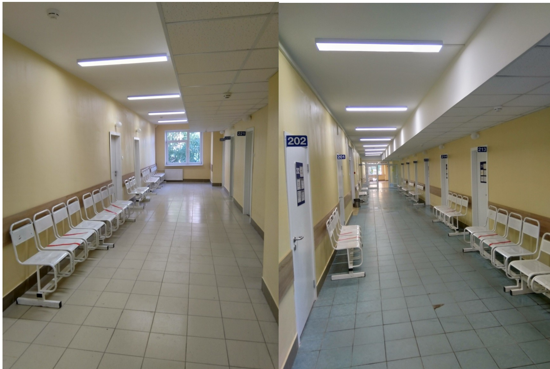
Поликлиника №111, ремонт коридора 2 этажа
