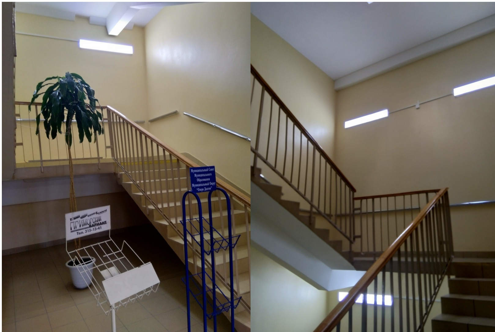
Поликлиника №111, ремонт центральной лестничной клетки
