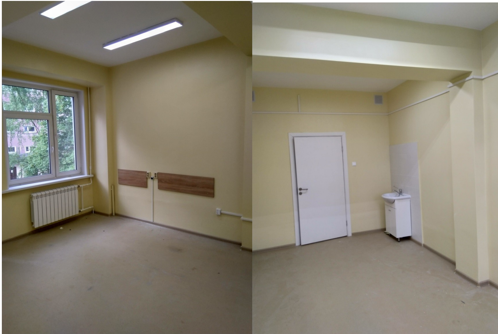
Поликлиника №111, ремонт кабинетов 2 этажа
