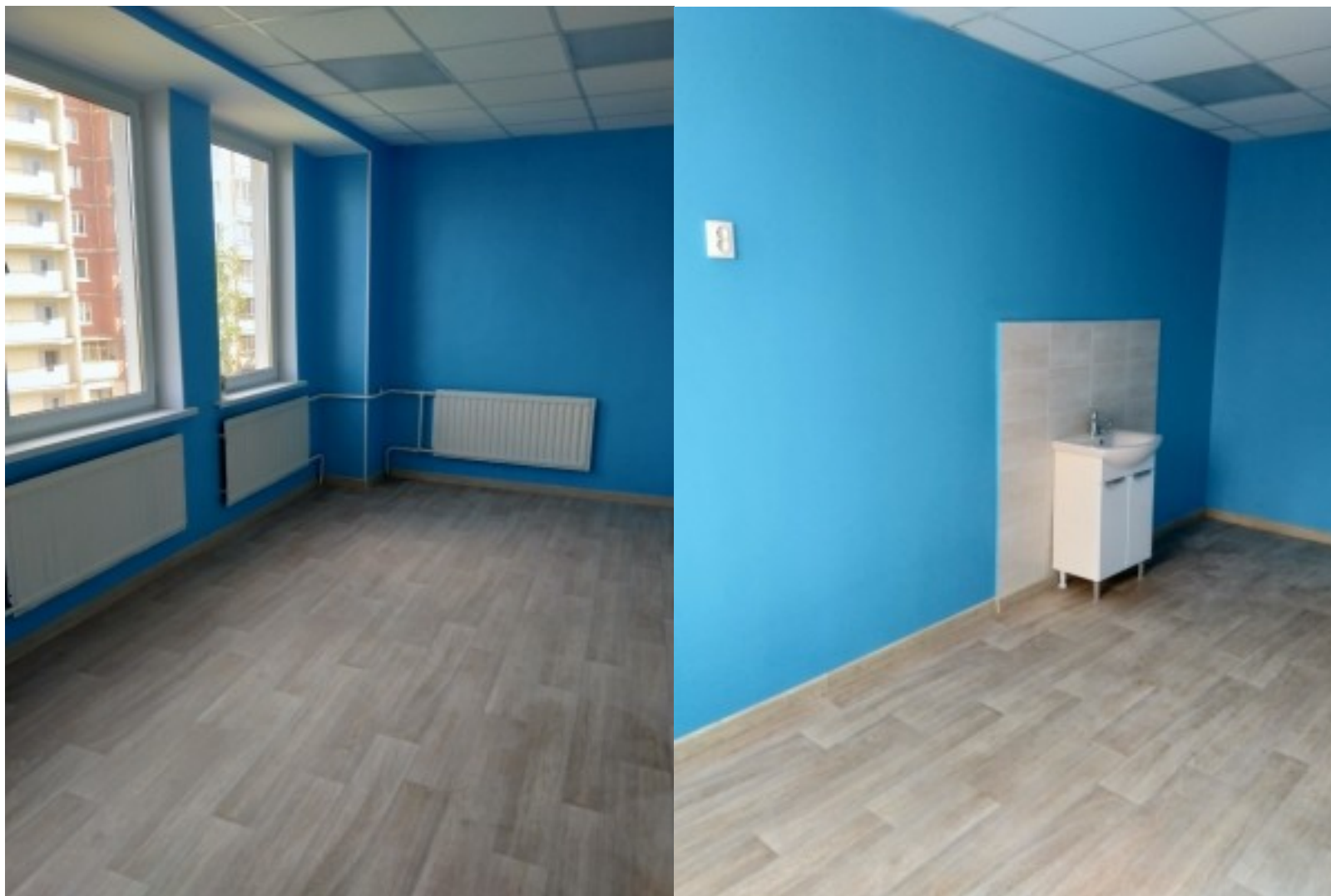
ДПО 77 ремонт кабинетов 3 этажа
